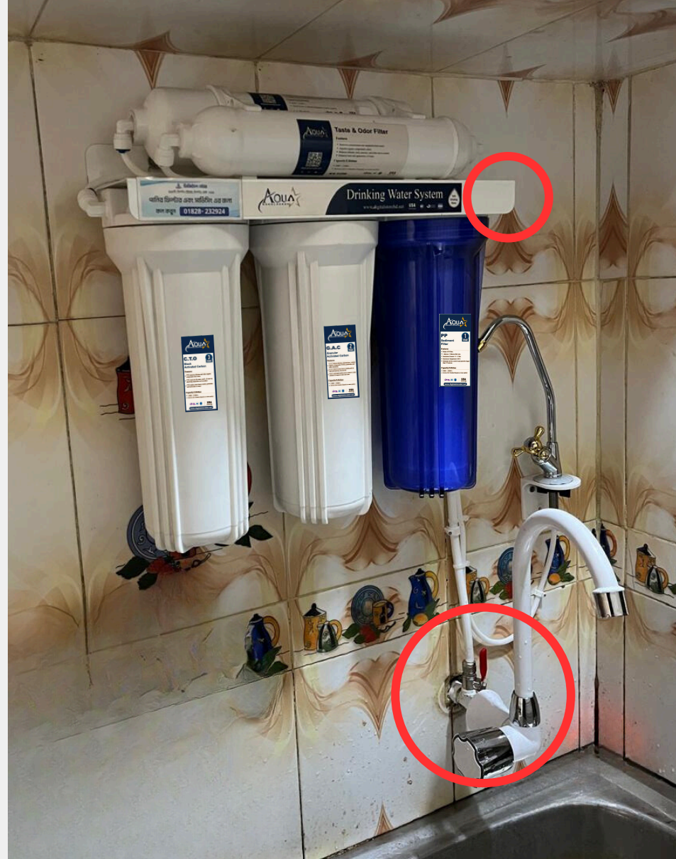
ইন্সটলেশন চিত্র - ১ 10mm পাইপ সেট করতে হবে
