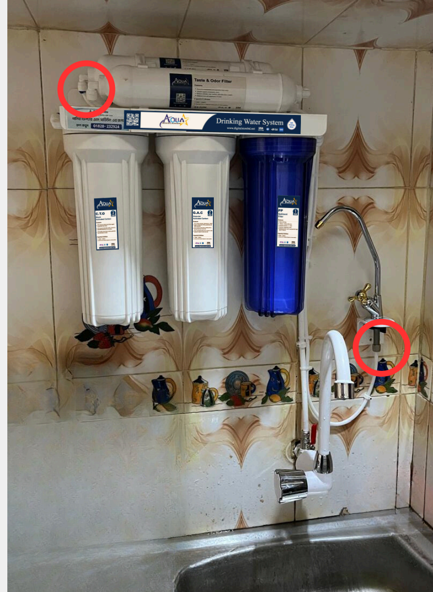
ইন্সটলেশন চিত্র - ২ 6mm পাইপ সেট করতে হবে
